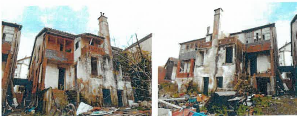
Fotografias 4-5: Aspeto dos imóveis durante a intervenção
