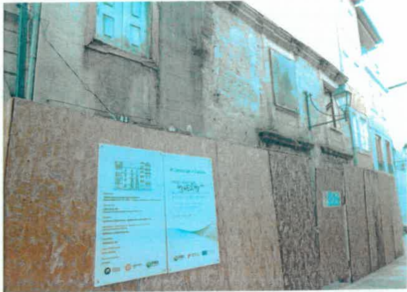
Fotografia 15: Aspeto atual do edifício do edifício da Rua Direita nº 83-89
