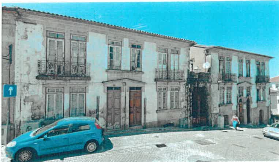
Fotografia 3: Aspeto dos imóveis antes da intervenção
