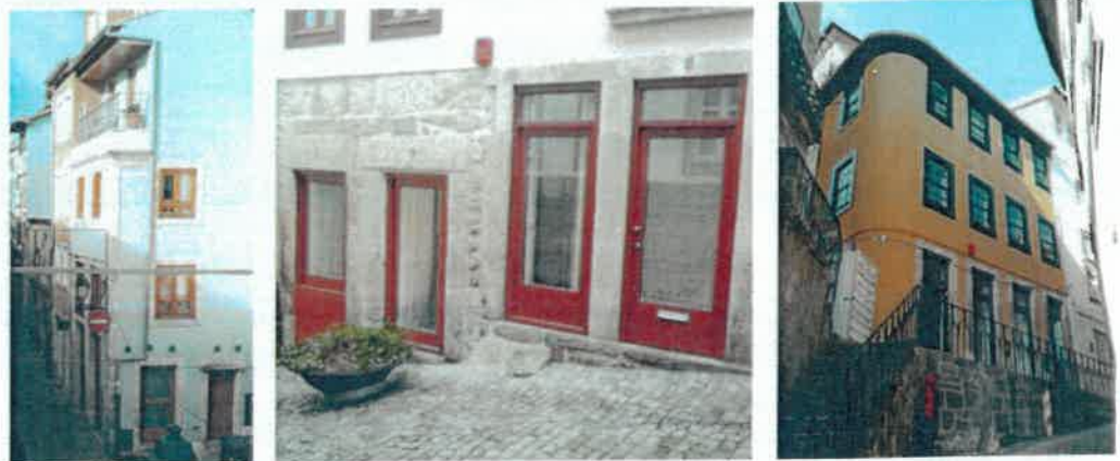
Fotografias 16-18: Imóveis da Rua Direita nº 91-97, da Rua Escura nº 11 e da Calçada da Vigia nº 7-17
