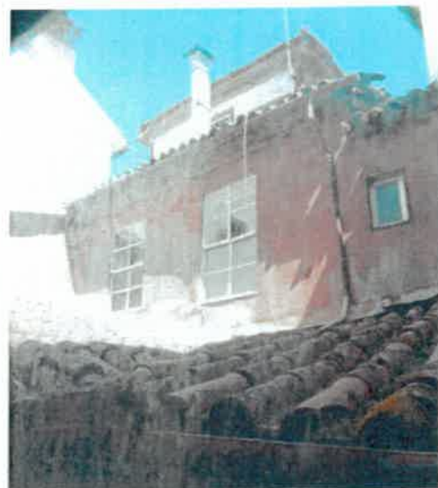
Fotografias 1-2: Aspeto do imóvel antes da intervenção
