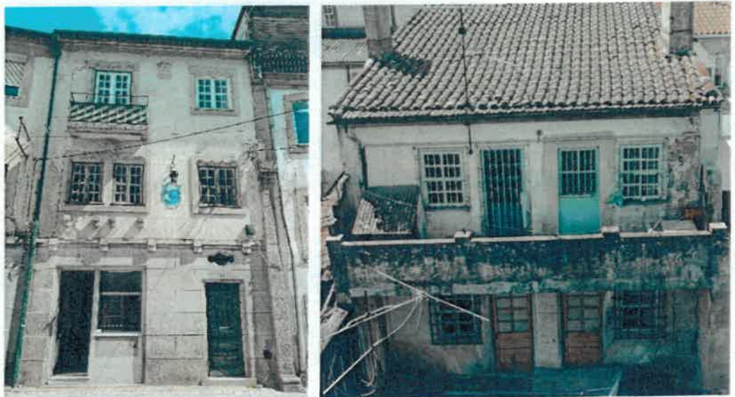
Fotografia 6-7: Aspeto do imóvel antes da intervenção
