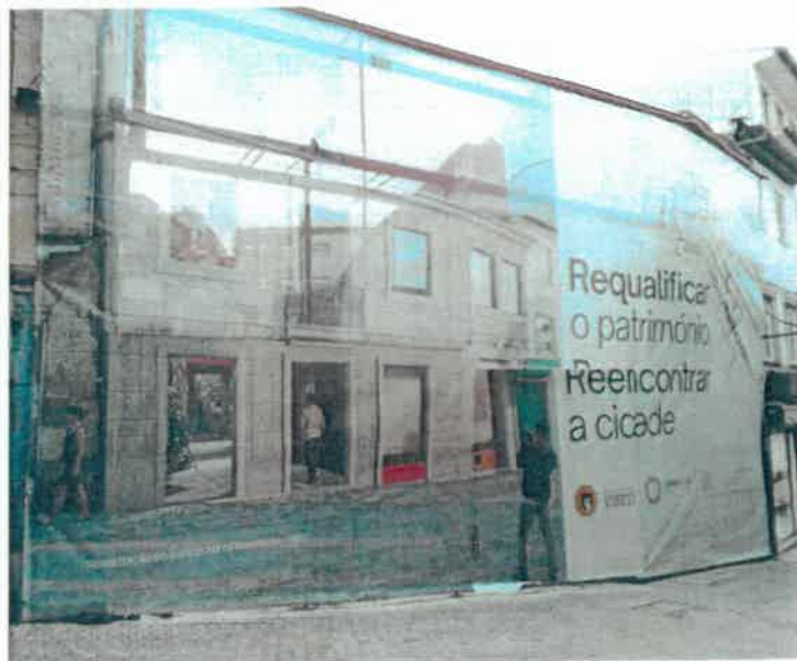
Fotografia 14: Aspeto atual do edifício do edifício da Rua Direita nº 219
