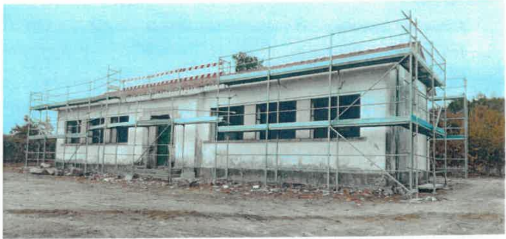
Fotografia 10: Aspeto do edifício, durante a intervenção
